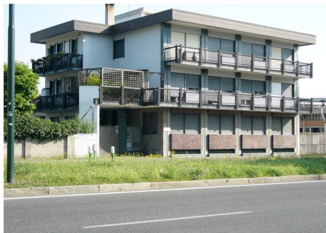
Stabilimento uffici C.A. Meccanica s.r.l. Via SANSOVINO 191/A Torino ITALY
